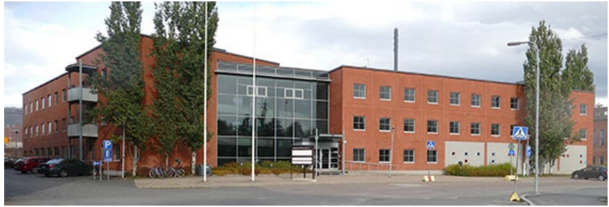
Kuva 6: Purettava toimistorakennus Pyhäjärven suunnasta.
